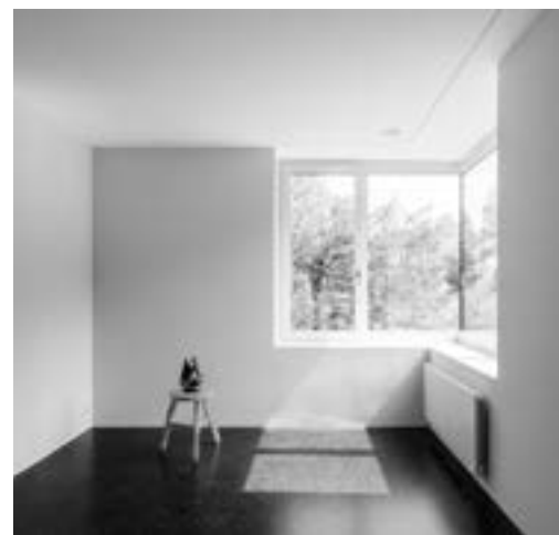
Der dunkle Gussasphalt speichert zusammen mit den Betondecken die Sonnenwärme.
