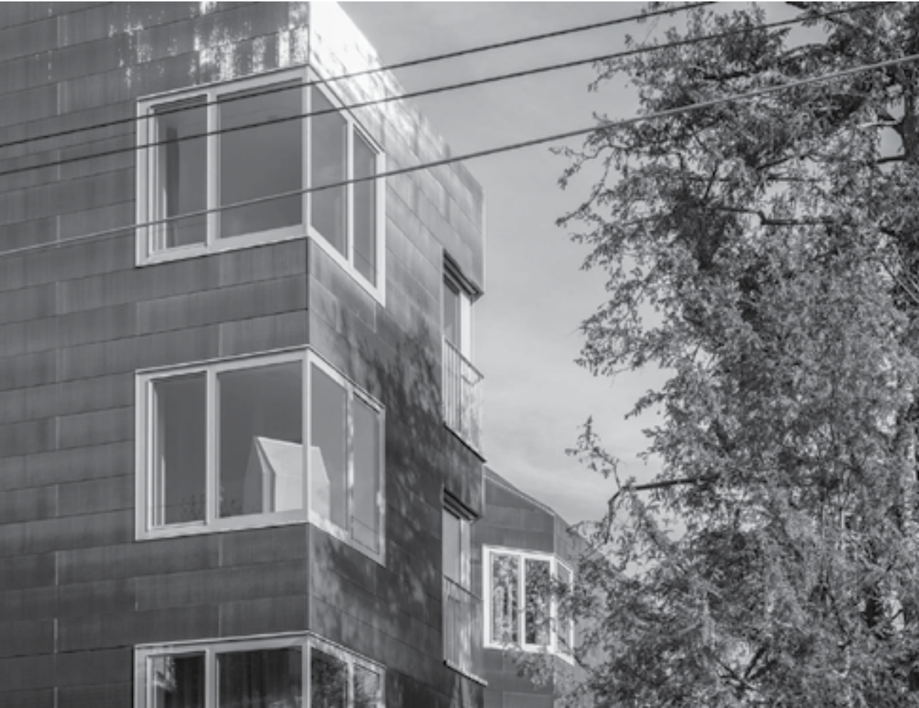
Die schimmernde Glashaut sucht den Bezug zum nahen See. Dass dahinter Photovoltaik ihren Dienst tut, bleibt zunächst verborgen.
