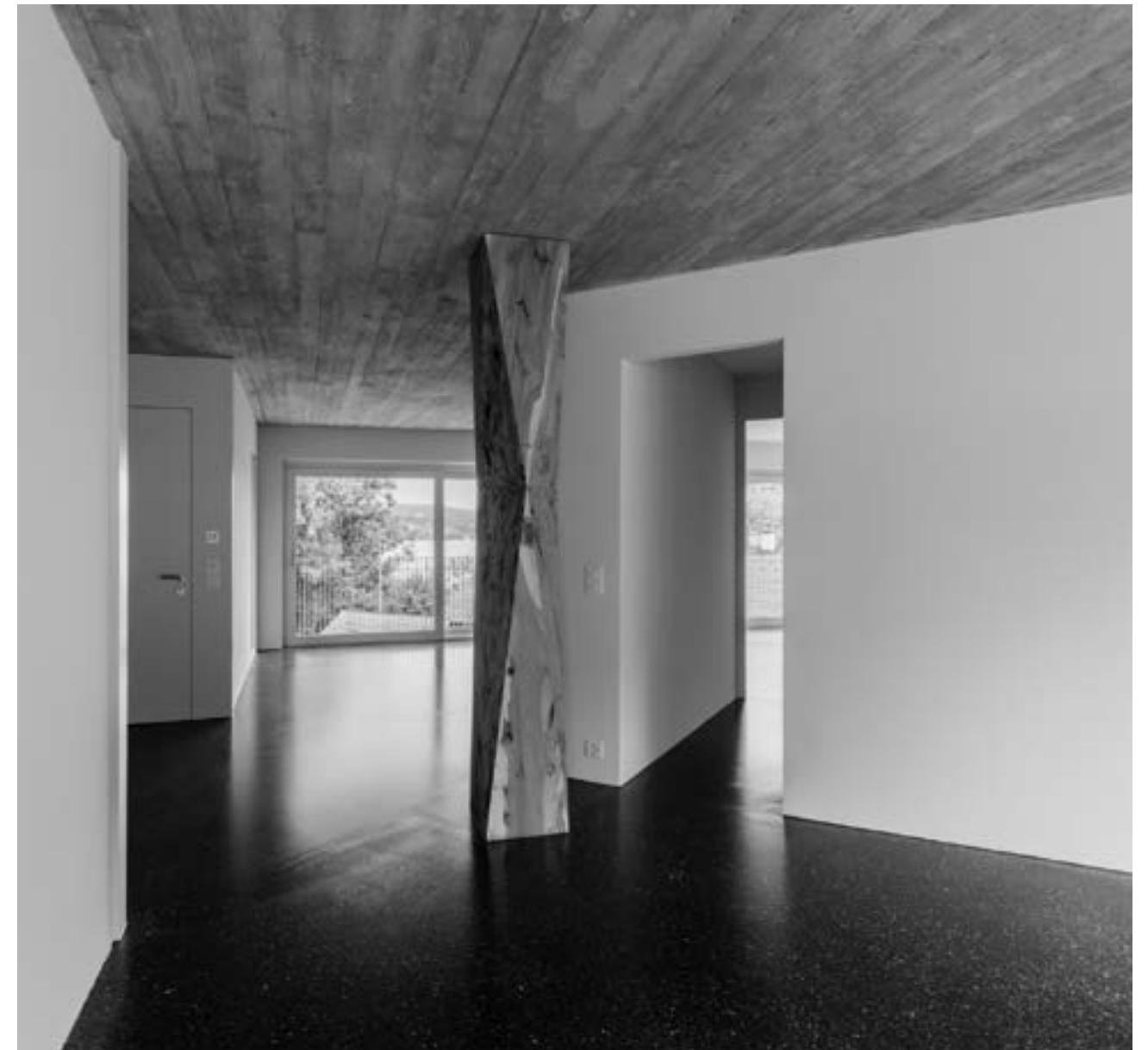
Der fließende Wohnraum verbindet See- und Hangseite. Eine alte Eibe musste dem Haus weichen. Ihre Bretter verkleiden nun die zentrale Stütze jeder Wohnung.
