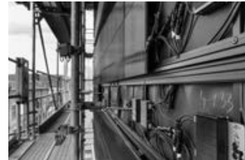
Die Fassadenkonstruktion ist eine Sonderanfertigung der Firma Gasser aus St. Gallen: Die Glaselemente hängen an Aluminiumschienen und werden mit Imbusschrauben durch die schmalen Fugen fixiert.
